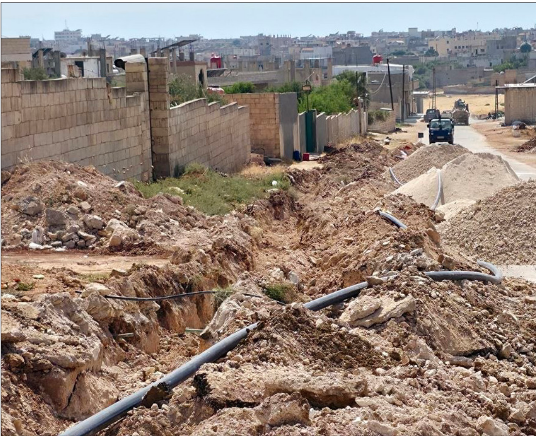
الشركة العامة لمياه الشرب والصرف الصحي نفذت أعمال توسعة واستبدال لشبكة المياه بمدينة حلفايا - 15 أيار 2026 (الشركة العامة لمياه الشرب)
