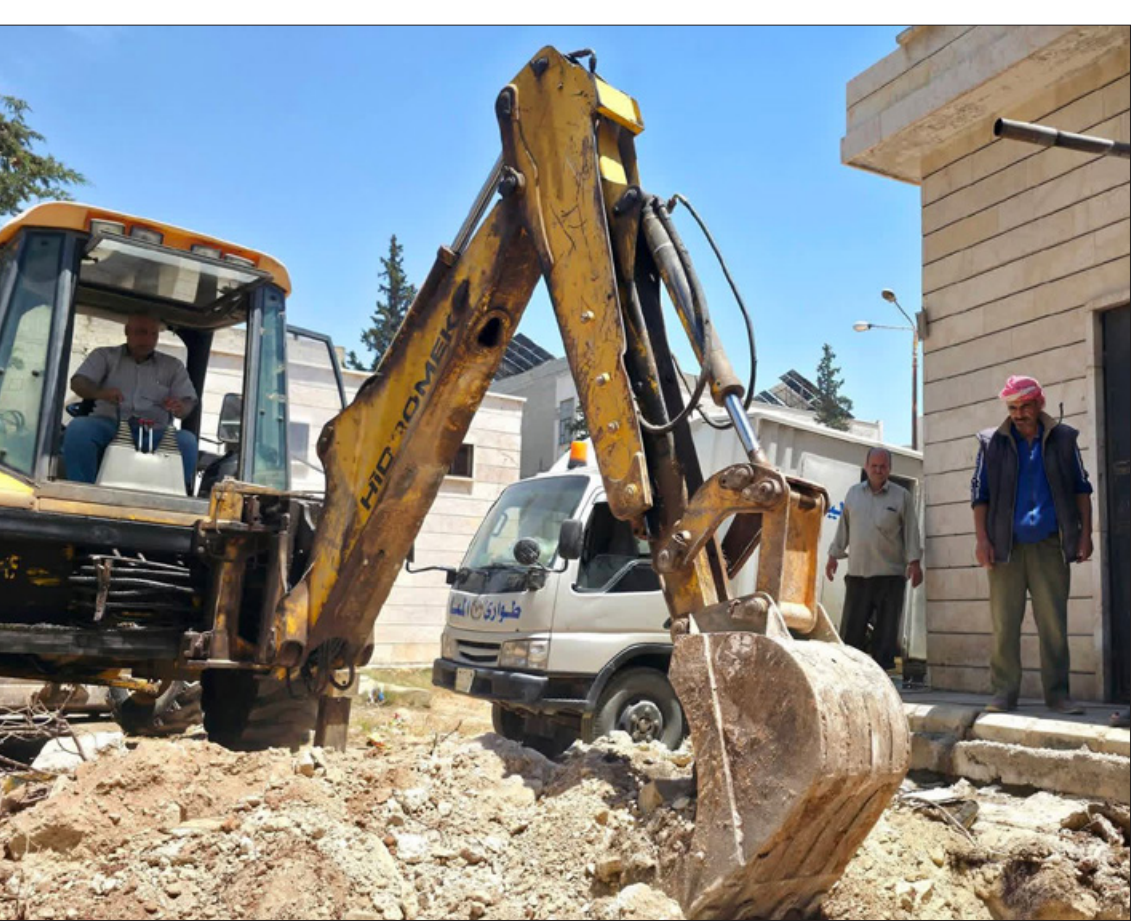
مارة صيانة شبكات بالشركة العامة لرياء الشرب في حماة تقوم بإصلاحات لتأمين واقع المياه بحي القصور - 20 حزيران 2026 الشركة العامة لرياء الشرب بحماة
