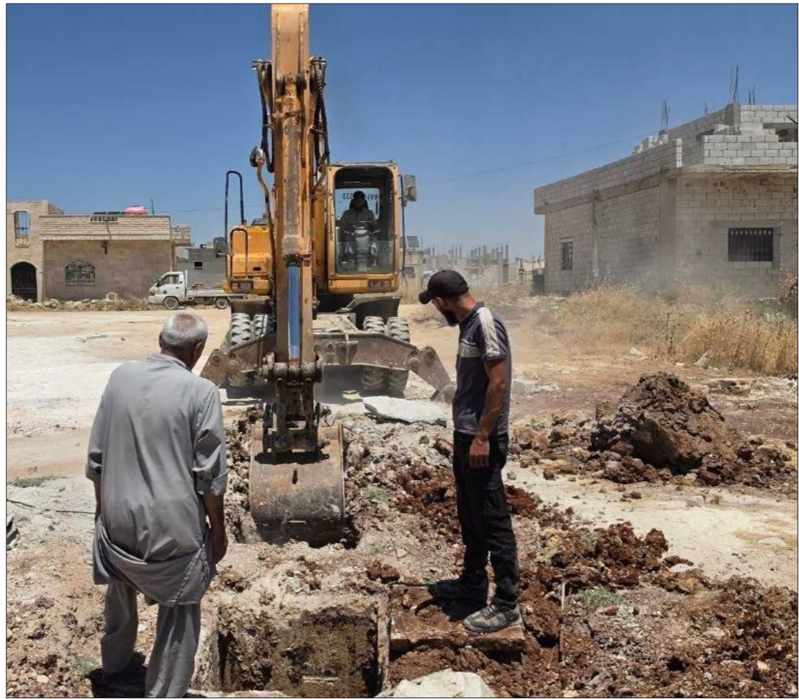
جانب من أعمال إعادة تأهيل منظومة مياه الشرب وشبكات الصرف الصحي في بلدة كفرزيتا - 30 حزيران 2026 (ملاحظة صفراء)
