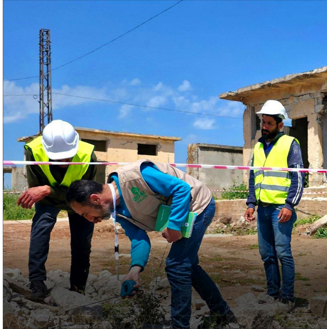
عمالون في المؤسسة العامة لهي الشرب بحماة بالتعاون مع منظمة "وكسفام" يعملون لتأهيل بئر المدرسة بكفرنبودة - 28 نيسان 2026 وزارة الثقافة
