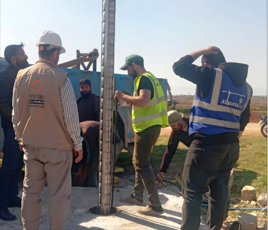
عمال من مؤسسة مياه حماة بالتعاون مع موظفين من منظمة "أورانج" يقومون بأعمال حفر محطة مياه في قرية لطمين بريف حماة - 25 نيسان 2026 (ملاحظة حماتا)
