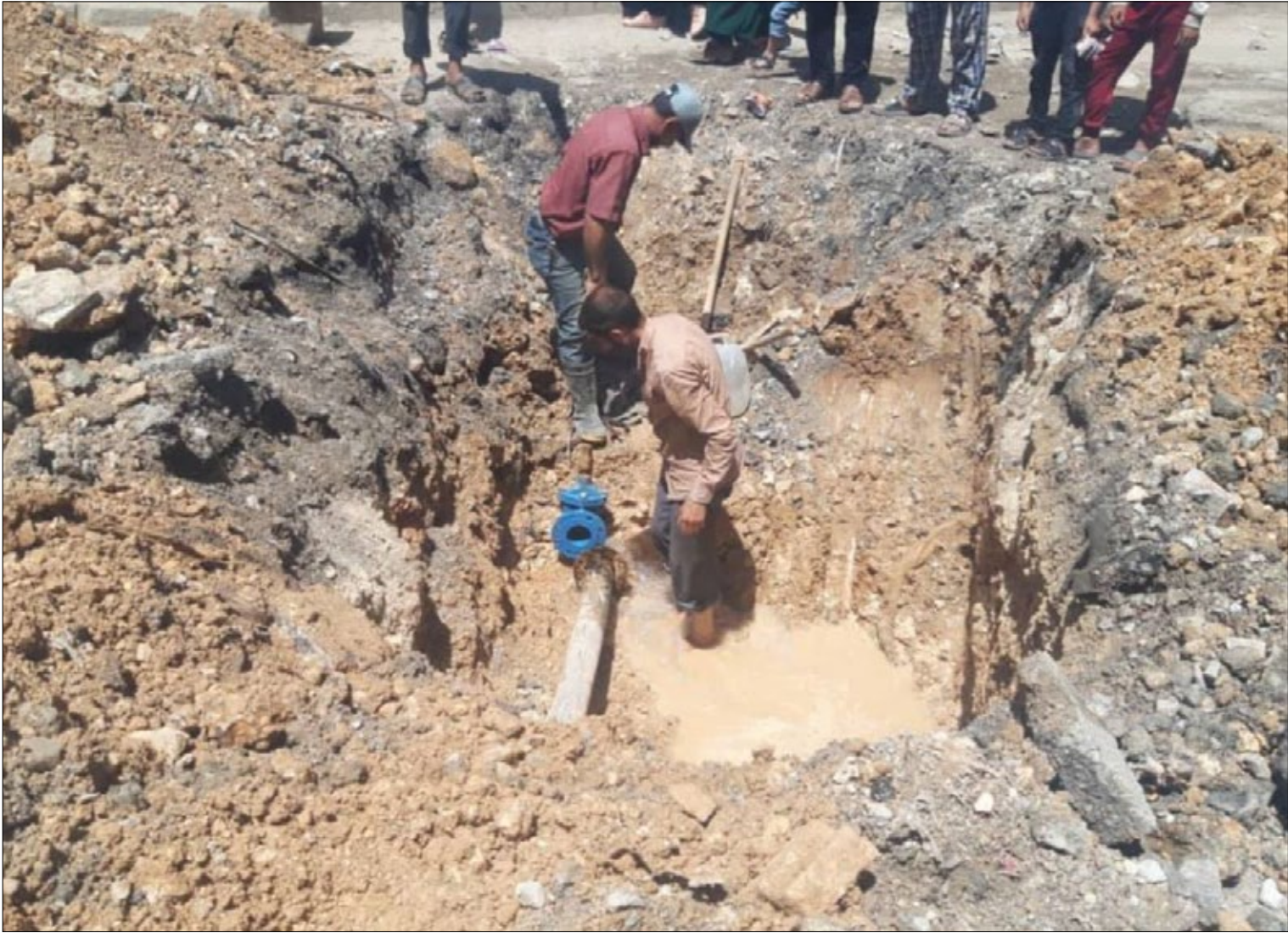
إصلاح شبكة المياه في حي الهك بحدثة حلب - 17 تموز 2025(مؤسسة مياه حلب/ فيسوالدا)
