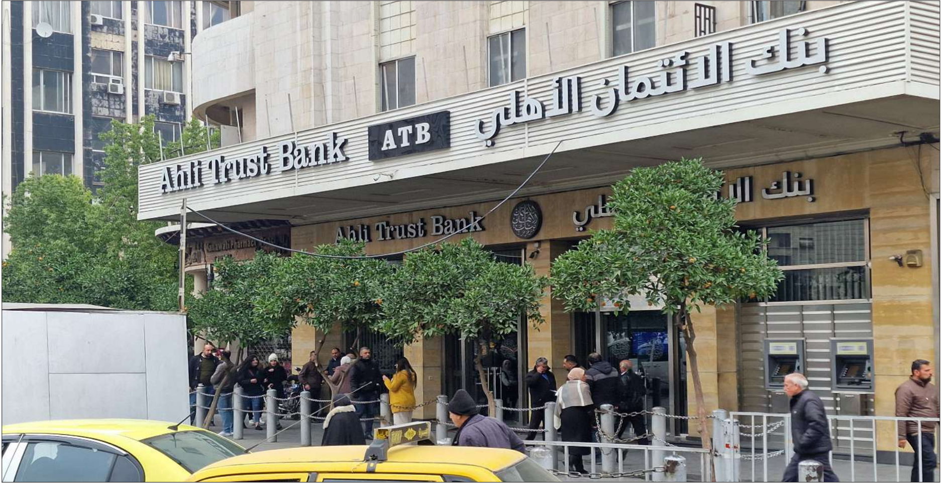
مبنى بنك الائتمان الأهلي في دمشق - 25 كانون الأول 2024 (عنب بلدي / أس الدولبي)
