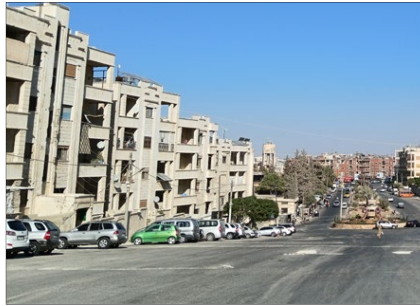
ترتفع إيجارات المنازل بشكل حوري في إدلب ولا تتناسب مع دخل الأفراد - 14 أيلول 2024 (عنب بلدي / سماح علوش)
