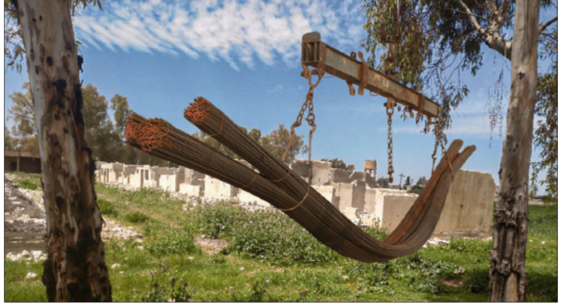
منزل مهدمه بريف درعا الغربي جزء تعرضها القصف - 16 من نيسان 2023 (تصوير عنب بلدي)
