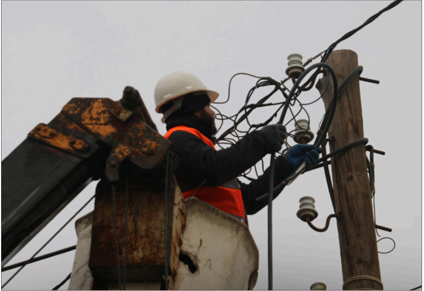
عامل في شركة الكهرباء "AK energy" يجري صيانة في مدينة اعزاز بريف حلب الشمالي - 18 كانون الثاني 2023 (AK energy) / فيس بوك
