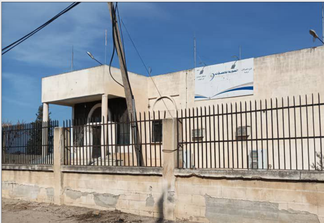
مبنى مركز الهاتف في منطقة تل شهاب بريف درعا الغربي - 11 كانون الثاني 2023 (عنب بلدي)
