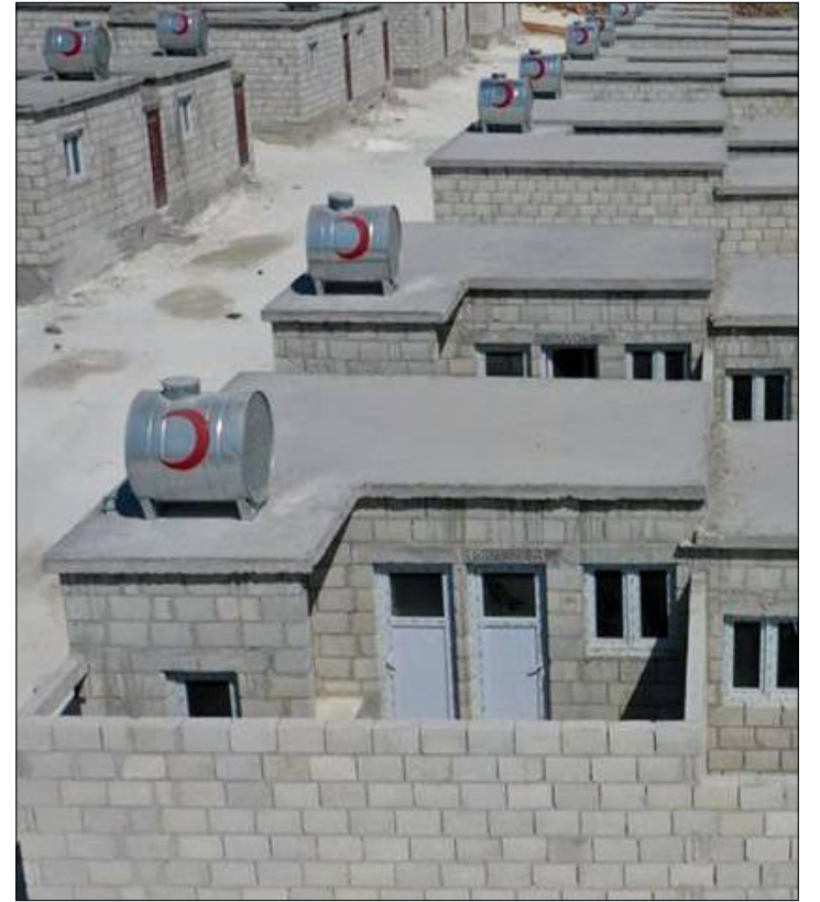
منازل أسمنتية بناها "الهلال الأحمر التركي" للنازحين في الشمال السوري (الهلال الأحمر التركي)
