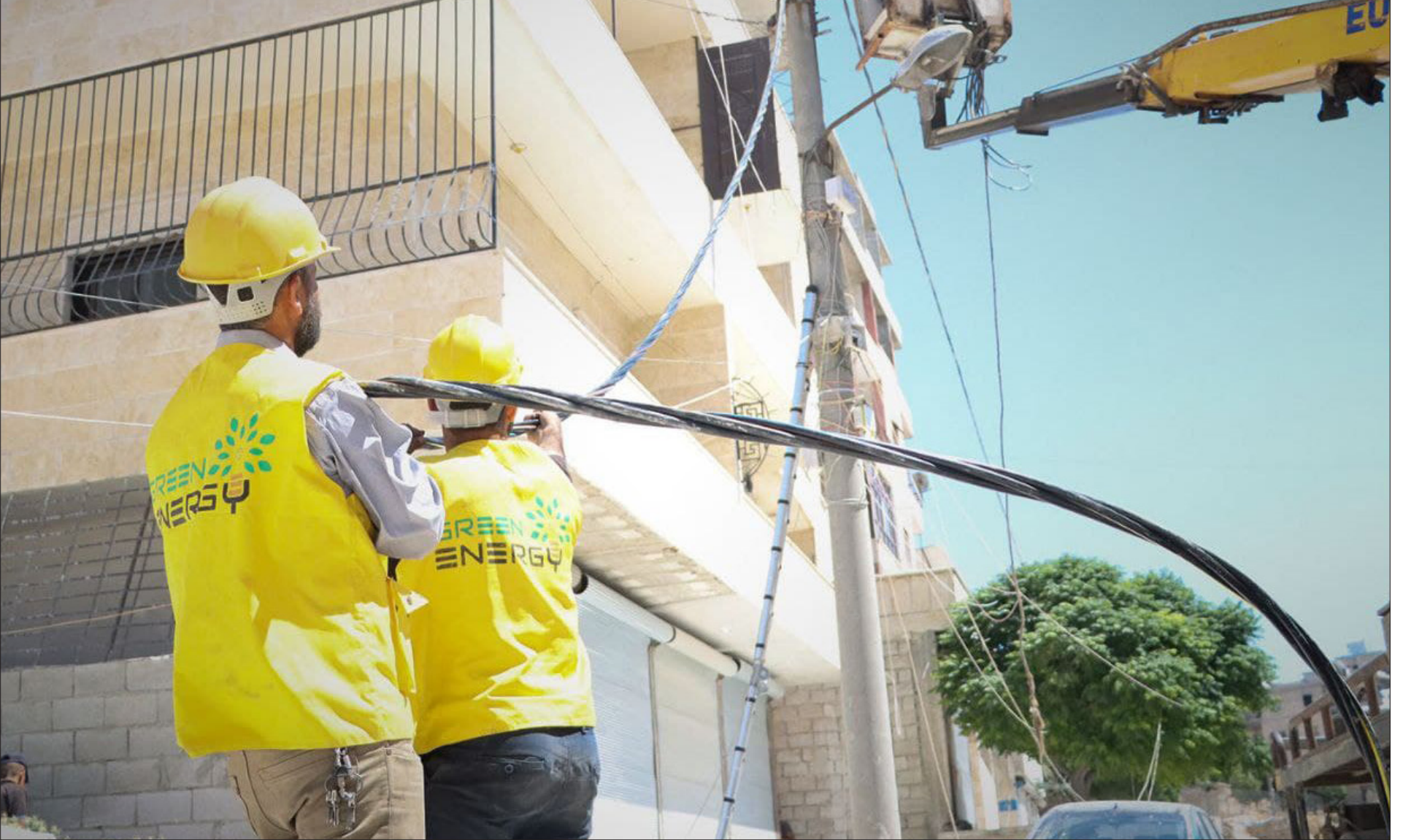
عمليات توصيل الكهرباء في مدينة سلقين شمالي إدلب من قبل عمال شركة "Green Energy" - حزيران 2021 (Green Energy)
