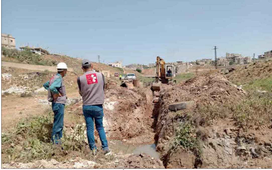
أعمال إصلاح الصرف الصحي في درعا البلد - نيسان 2021 (مجلس محافظة درعا)
