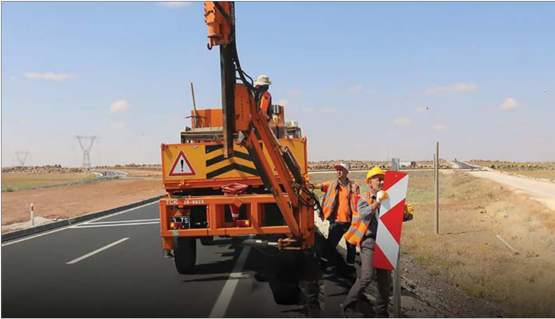
أعمال تخطيط وإضافة لوحات إشارات المرور الطرقية على اللوتستراد المحلي الشرقي لمدينة الراعي (المجلس المدني في مدينة الراعي)
