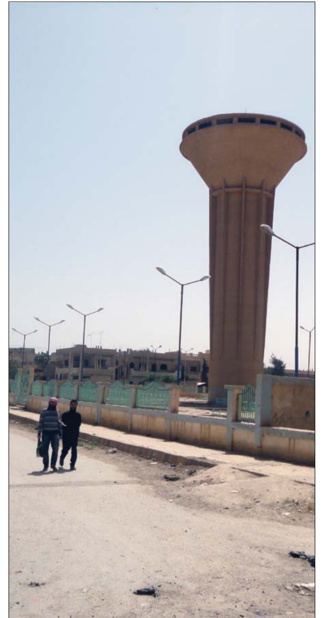
خزان مياه في مدينة الميادين شرق دير الزور (أرشيف عنب بلدي) 2013
