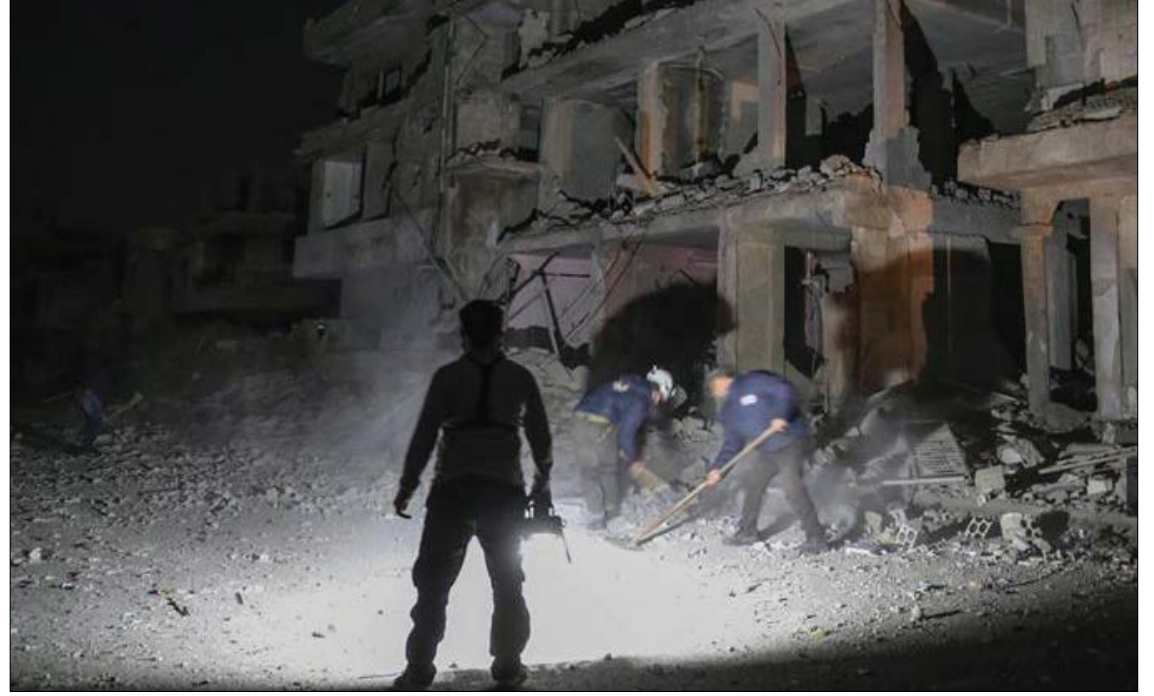
أضرار مادية في حي طريق السد بمدينة درعا جراء القصف بصاروخ "فيل" - الخميس 9 شباط 2017 (بأ)
