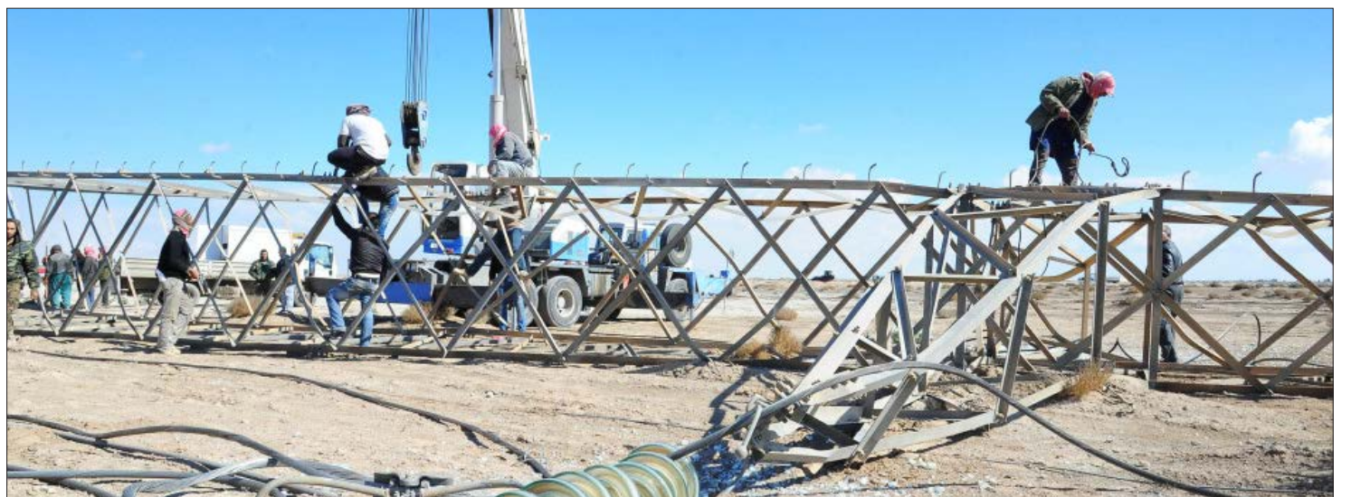
إصلاح إعطال أبراج الكهرباء في سوريا (الترن)
