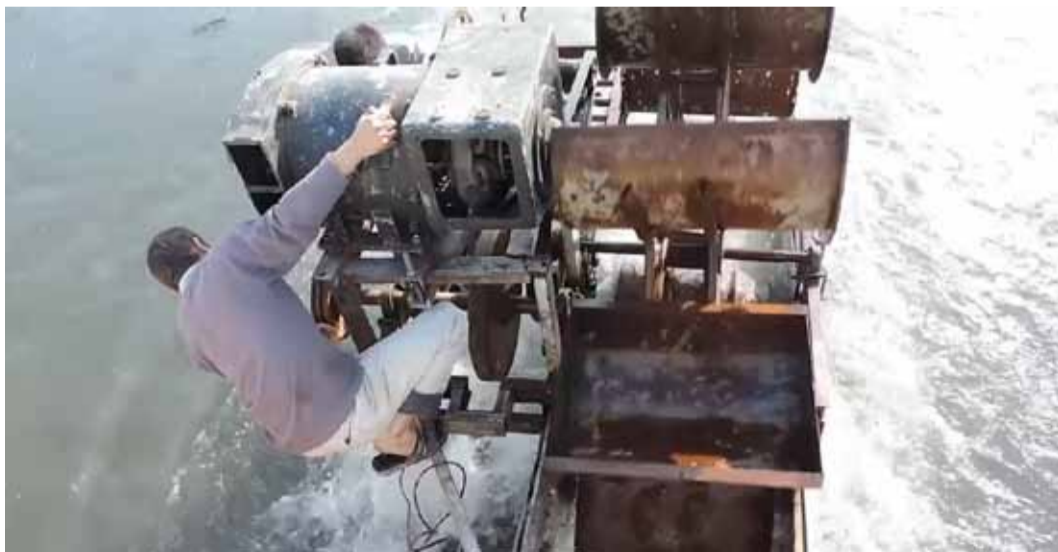
إحدى العنقافات على أطراف نهر قويق لتوليد طاقة تعتمد على إعادة تدوير مخلفات بعض الآلات الأخرى، وتعطي العنفة 100 أمبير تقريباً تغطي حوالي 100 منزل وتعمل 24 ساعة. الصورة وكالة سمات
