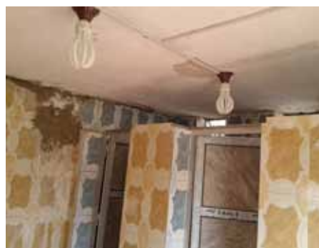
عمليات الترميم في مدرسة ذات النطاقين في معرة النعمان
