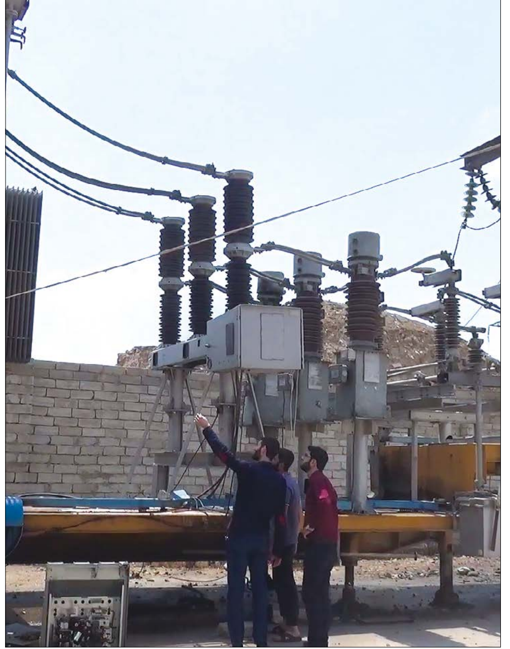
عمال صيانة في محطة تحويل كهربائي بطنب - (عنب بلدي)
