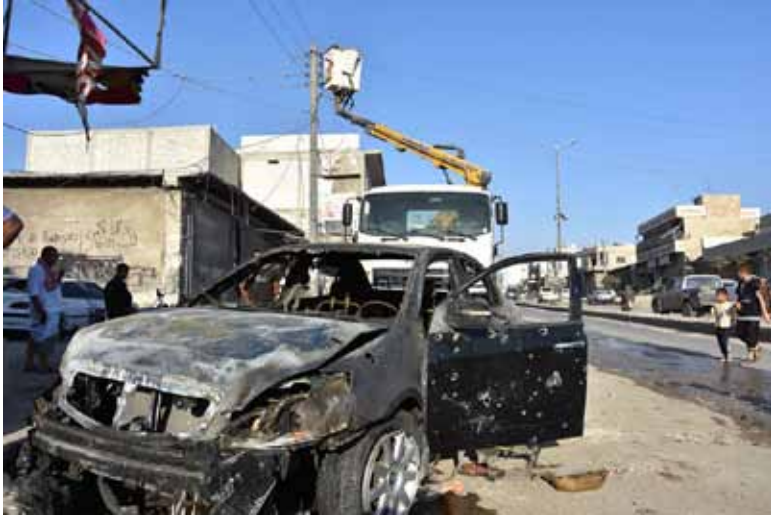
عمال الكهرباء في مدينة الأتارب | سوريثنا
