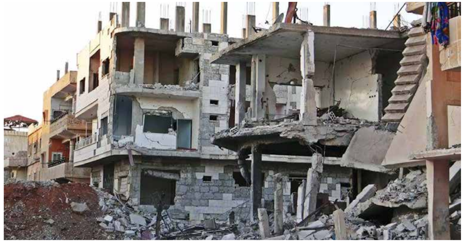
تدمير أكثر من ٧٠٪ من المنازل في بعض مناطق درعا (الصورة من الانترنت)
