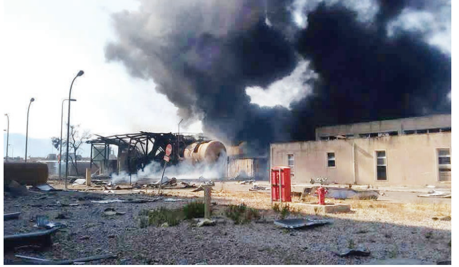
الحرائق في محطة زيزون الحرارية - السبت 1 آب
