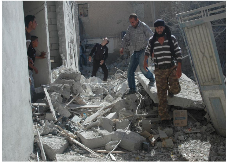
مبنى خلف التجنيد، أثار الدمار جراء القصف
