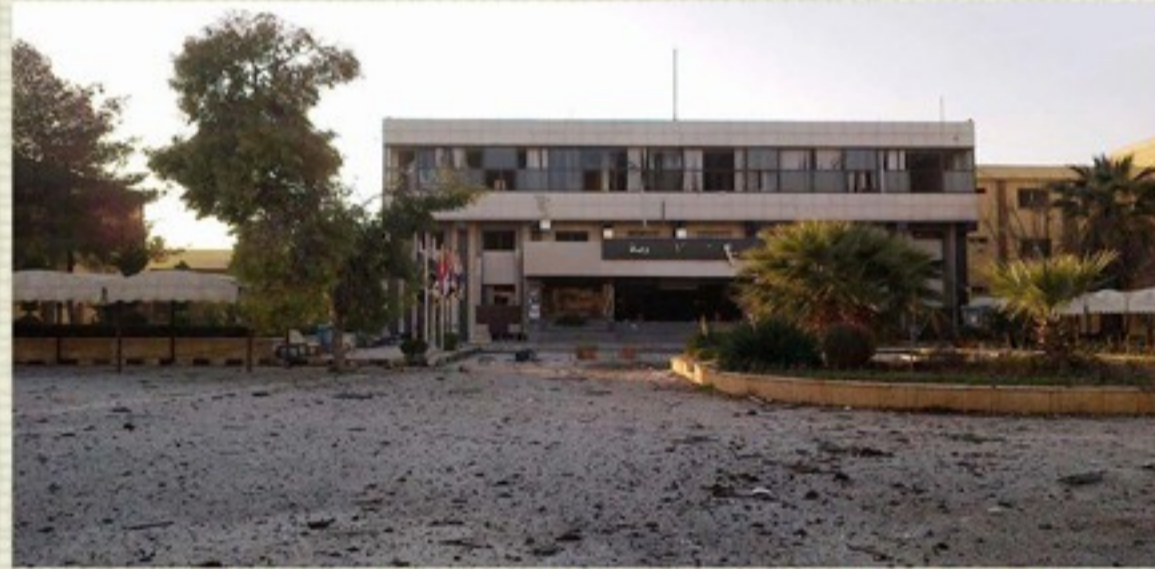
القصف الذي طال كلية الهندسة المعمارية في تاريخ 15/01/2013
