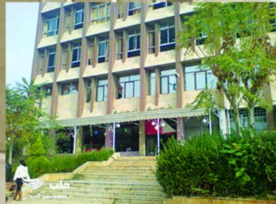
الواجهة الرئيسية لكلية الهندسة المدنية، ويلاحظ في الصورة أثار التفريب
