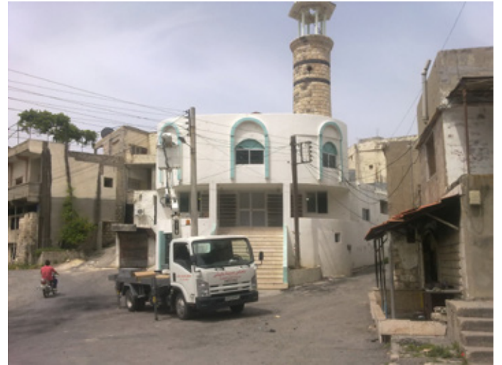
تركيب لمبات إنارة في شوارع بلدة البيضا
